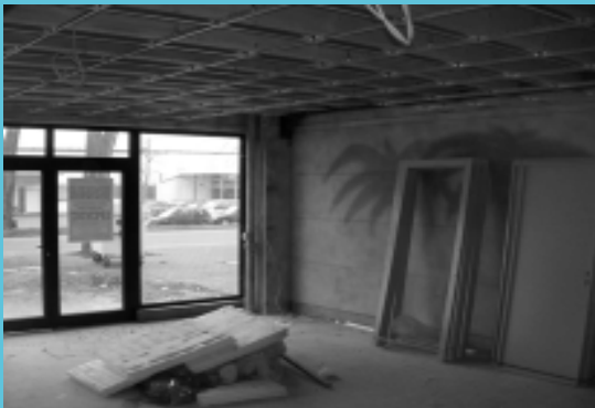
Bauarbeiten im großen Gruppenraum mit Fensterfront.
