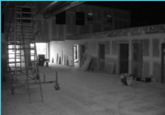
Blick aus der Veranstaltungshalle auf den Gruppenraumtrakt und den Technikraum (oben).
